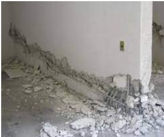
شکل (۳-۱۶): سطح آسیب ۳، دیوار برشی در رفتار غالب برش
