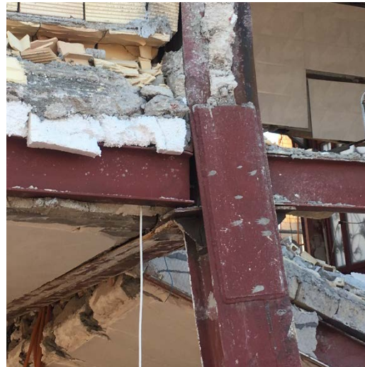
شکل (۱-۲): نمونه‌ای از آسیب‌های ایجاد شده در اتصالات سامانه‌ی باربر قاب خمشی در یک ساختمان فولادی
